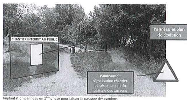
Implantation panneau en 1 ère phase pour laisser le passage des camions
