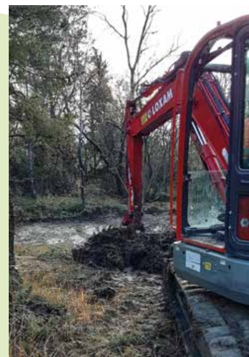
Travaux de restauration de mares sur la Butte du Hutrel
