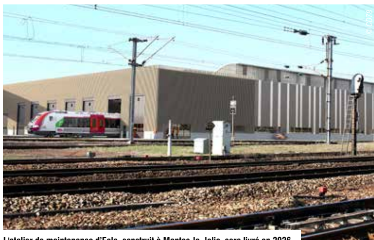
L'atelier de maintenance d'Eole, construit à Mantes-la-Jolie, sera livré en 2026.
