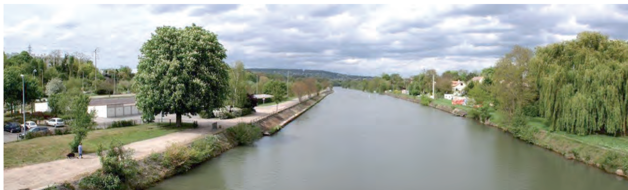
3- Vue depuis la passerelle piétonne de liaison entre Carrières-sous-Poissy et l'Île de la Dérivation (à droite). Les hauteurs boisées de l'Hautil cadrent fortement le paysage.
