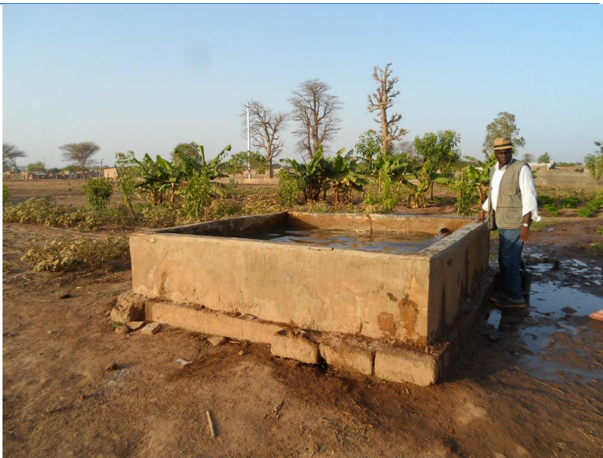
Photo 16: bassin de rétention de l'eau
