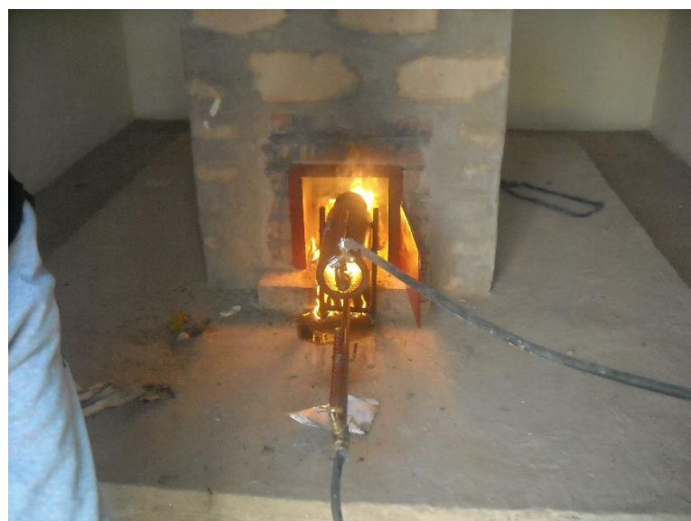
Photo 6 : démonstration du fonctionnement d'un incinérateur de type Montfort, poste de santé Mery, prise le 15/04/19
