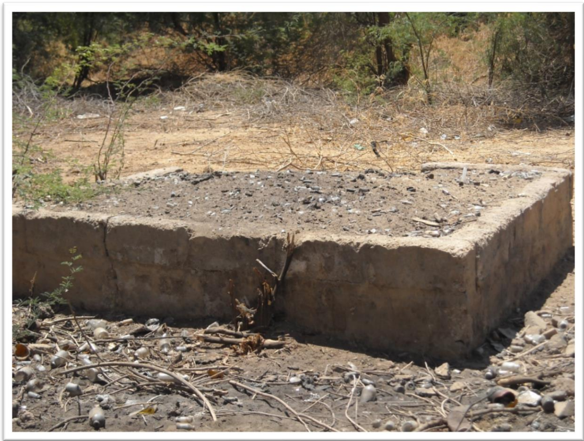
Image 1: Fosse d'incinération des déchets biomédicaux avant l'arrivée des incinérateurs, Centre de santé de Podor.
