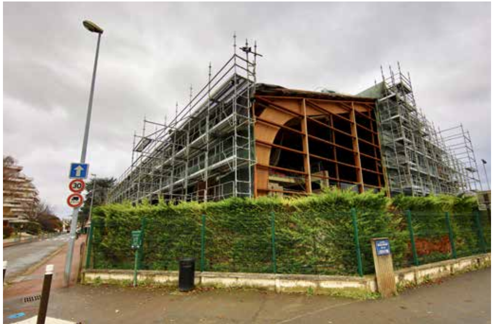
La réfection du gymnase Marcel-Villeneuve, au Pecq, estimée à 2,6 M€, est soutenue par le Département à hauteur de 600 000€.
