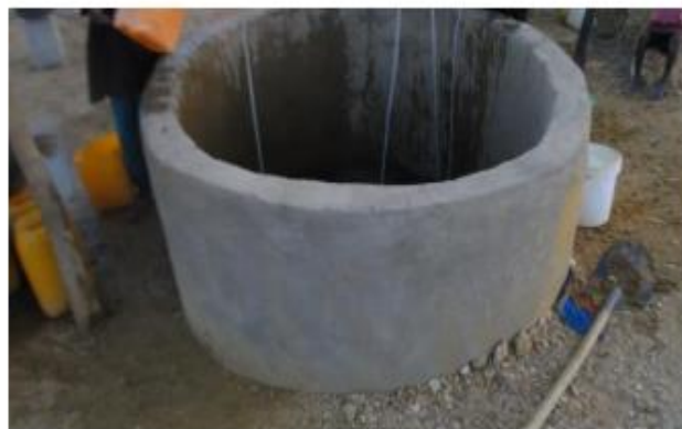
Puits pour l'approvisionnement du jardin
