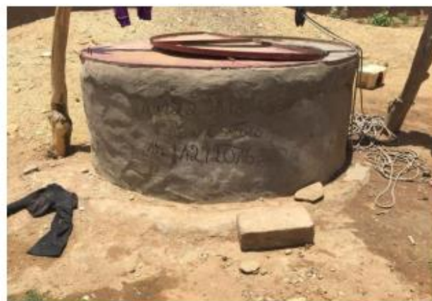
Puits construit pour l'irrigation du périmètre
