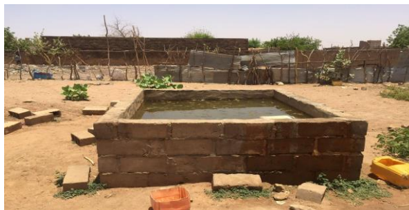
Réservoir du périmètre de maraichage
