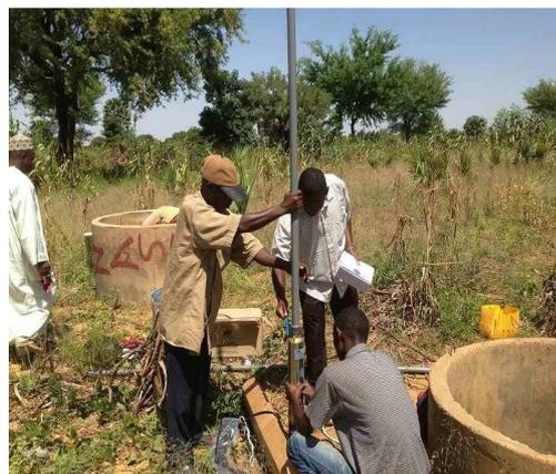
**Figure 16 : Installation d'un système de pompe solaire pour l'irrigation d'un champ**
