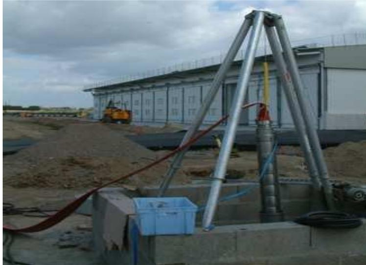
**Figure 10 : pompes à refoulement pour eaux profondes**
