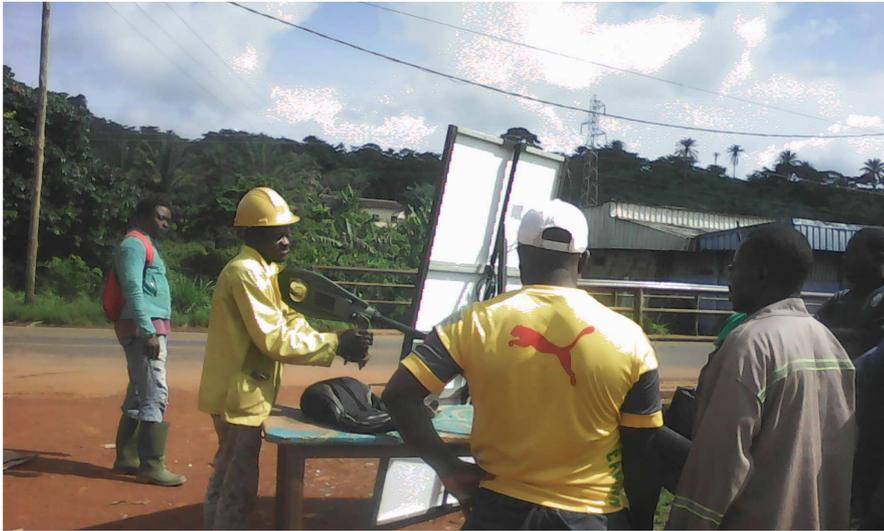
**Figure 34 : Installation d'un lampadaire solaire à l'Ouest du Cameroun**
