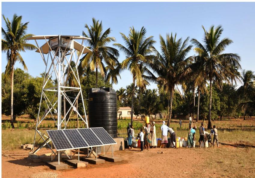
**Figure 11 : Installation d'un pompage solaire au Mozambique**
