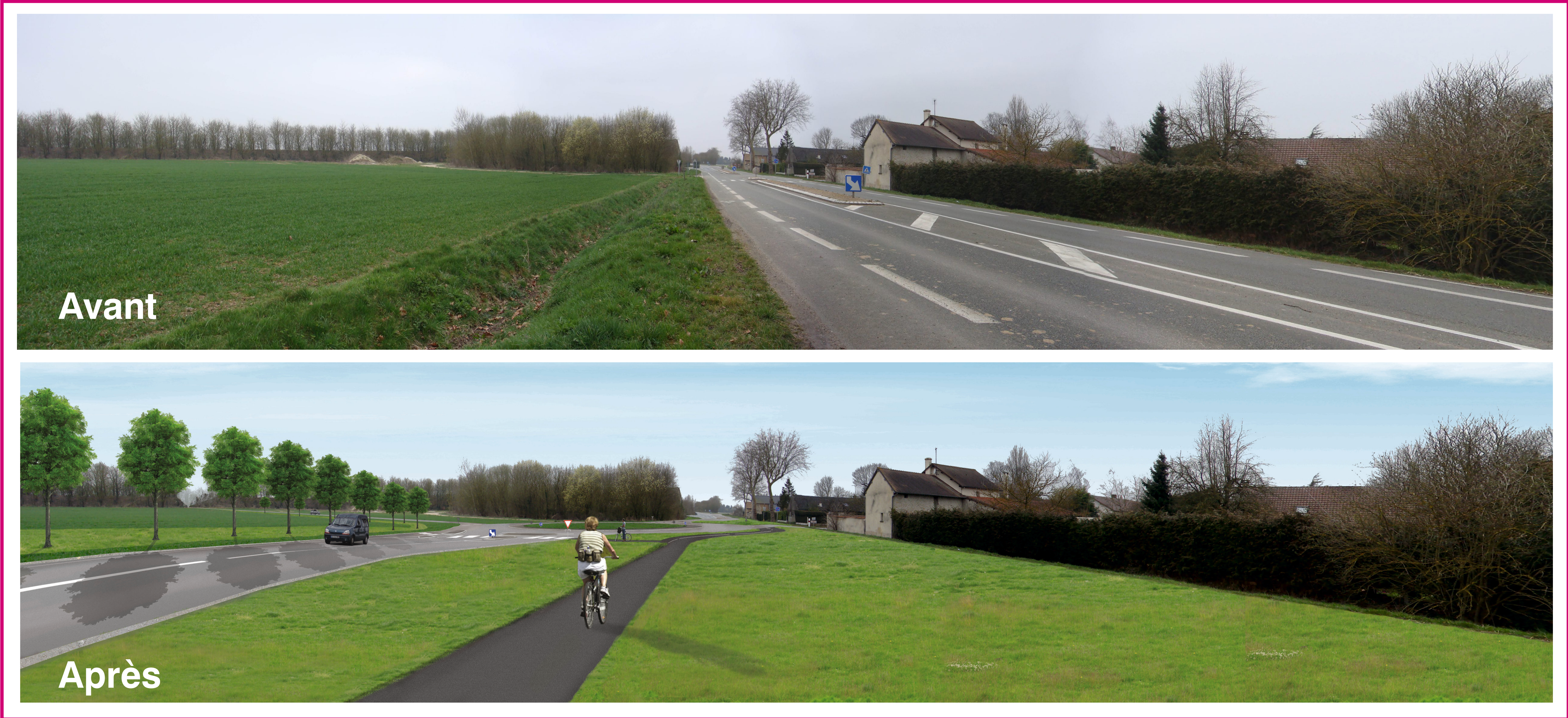
Vue de la RD 912 avant et après l’aménagement
