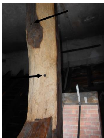
Photo n° 1 Localisation : 3ème étage - Grenier Ouvrage : Charpentes Indices : Poutres Description : Traces d'attaque de capricone et traitement par imprégnation.
