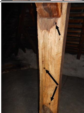
Photo n° 2 Localisation : 3ème étage - Grenier Ouvrage : Charpentes Indices : Poutres Description : Traces d'attaque de capricone et traitement par imprégnation.
