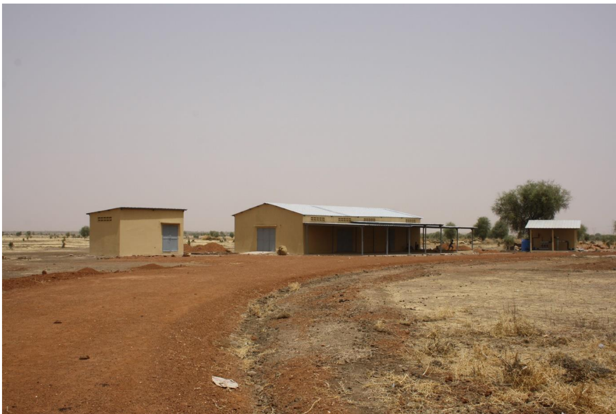
L'entrée du périmètre maraîcher, avec les bâtiments administratifs, les espaces de stockage et le système de forage
