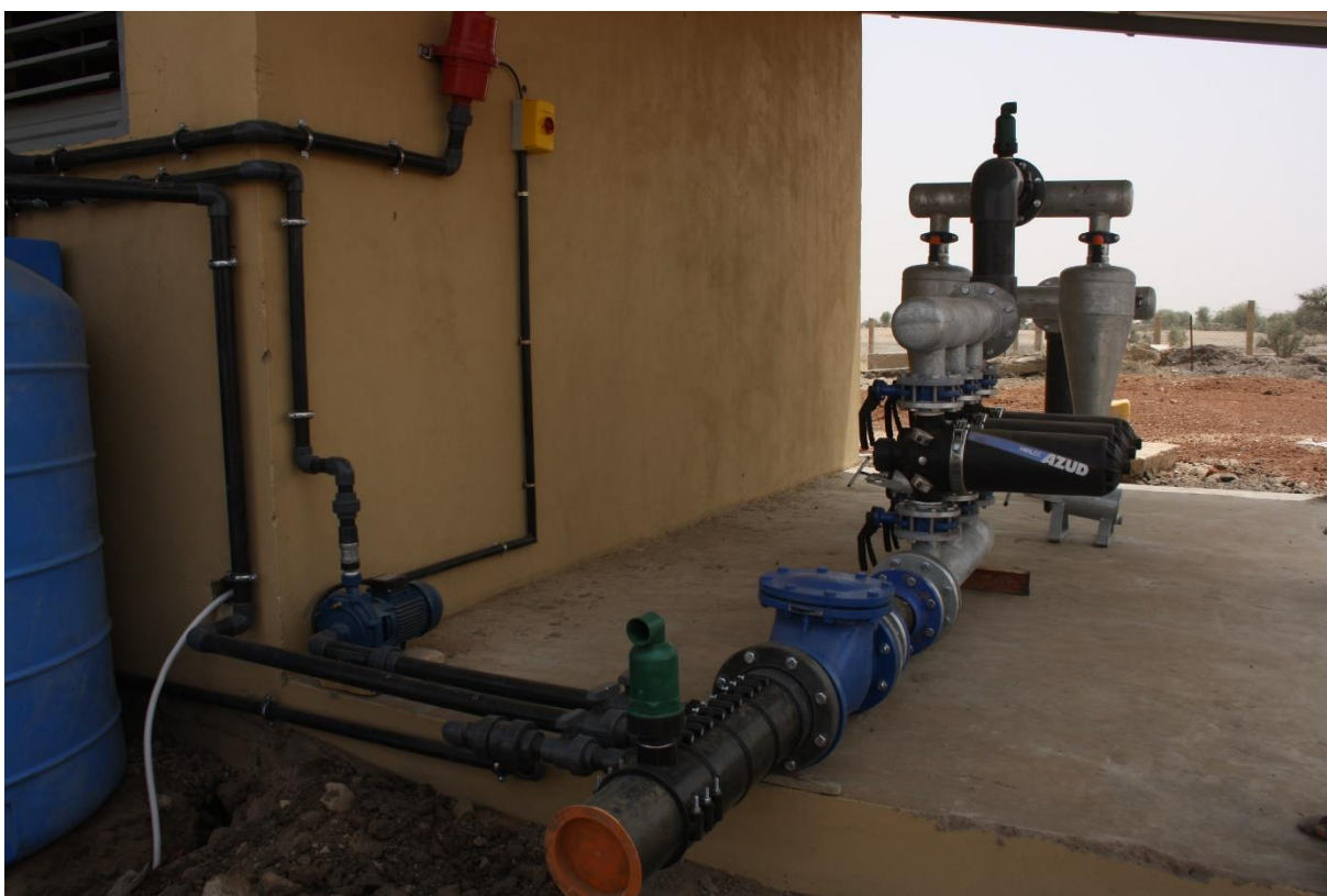
Le système de forage, qui alimentera en eau l'ensemble des projets agricoles
