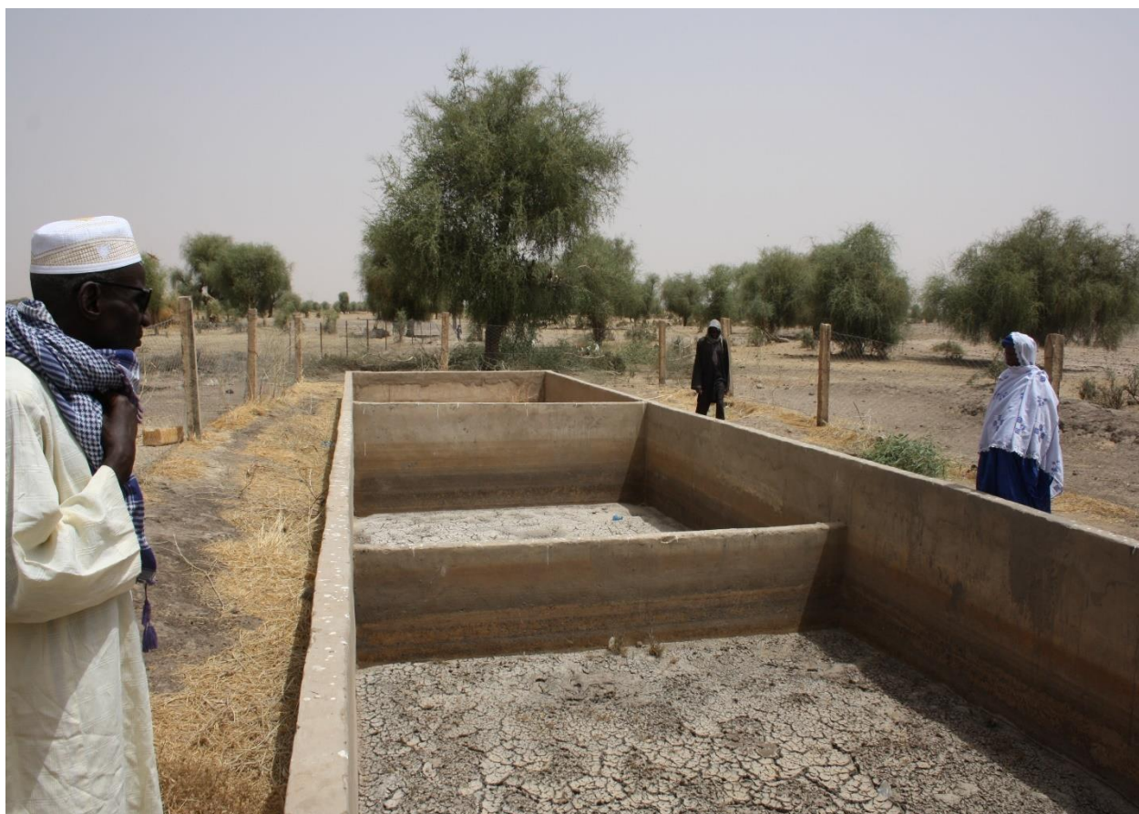
Les bassins restent vides durant la période sèche, entre décembre et juin – CdA - 2017
