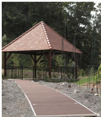
Aménagement d'un rond point à Bonnieres-sur-Seine
