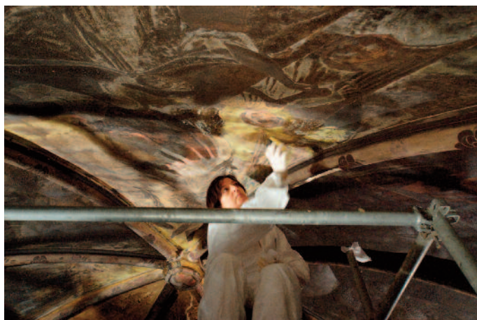
Décontamination et nettoyage de la voûte de la chapelle du Sacré-Cœur de Sainte-Marguerite du Vésinet par Marie Parant après l'incendie de 2009.
