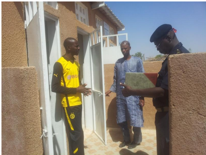
Suivi utilisation et entretien des blocs sanitaires dans l'école de Darou Khayri à Ranérou par le comité technique
