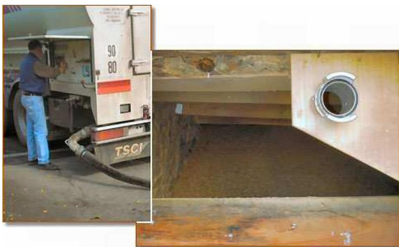
La livraison de granulé en vrac se fait par l'intermédiaire d'un camion citerne compartimenté, équipé d'un souffleur et de tubes souples allant de 20 à 40 mètres. Via cette méthode, le chargement du combustible est facilité.
