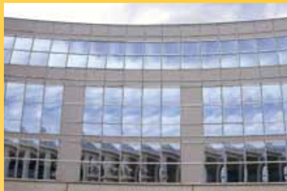
Nouvelle façade vue de jour.
