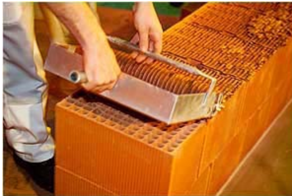
pose de briques « monomur »
