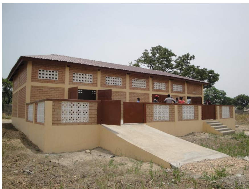
Le magasin de stockage construit dans le cadre du programme 2010-2103
