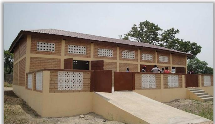
**Photo 10 :** le magasin de stockage du maïs, d'une capacité de 300 tonnes, est construit en briques de terre
