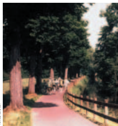
F. TORTEU/CETE EST Chemin de halage transformé en voie verte (enrobé rouge) dans le Bas-Rhin avec garde-corps
