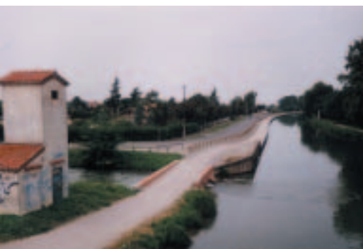
Piste cyclable-voie verte traitée en grave émulsion le long du canal latéral à la Garonne
