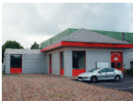
Les travaux d'extension du gymnase devraient débuter à l'automne prochain
