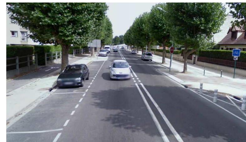
Figure 78 : RD 48 dans le centre d'Andrésy (rue du général Schweisguth)
