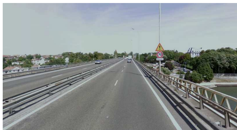
Figure 70 : RN 184 au niveau du franchissement de la Seine
