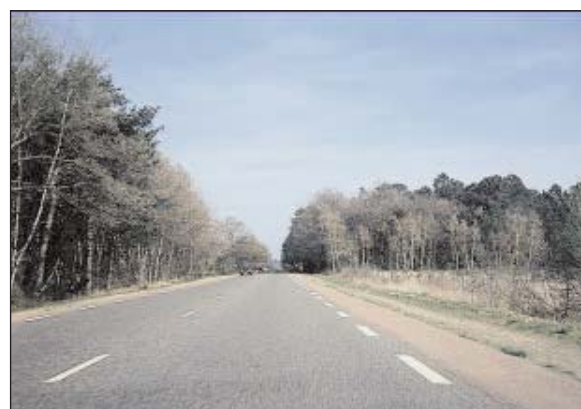
L'accotement avec un bon revêtement convient dans de nombreux cas.
