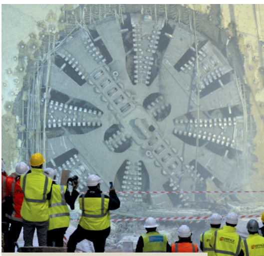
Arrivée du tunnelier Nolwenn (82 mètres de long) dans la gare souterraine de Viroflay Rive Gauche.
