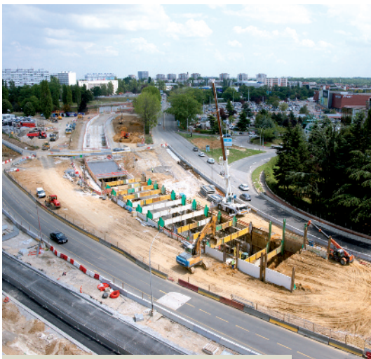
Trois ans de travaux ont été nécessaires pour aménager l'arrivée du tram à Vélizy. À terme, le T6 attend plus de 80 000 voyageurs par jour.
